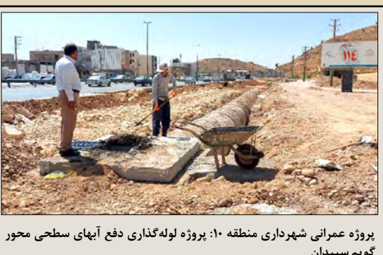
پروژه عمرانی شهرداری منطقه ۱۰: پروژه لوله‌گذاری دفع آبهای سطحی محور گویم سپیدان
