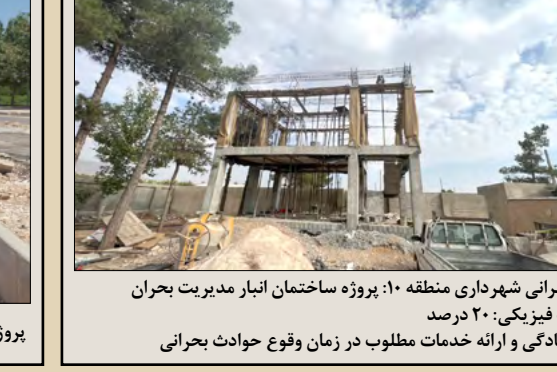
پروژه عمرانی شهرداری منطقه ۱۰: پروژه ساختمان انبار مدیریت بحران پیشرفت فیزیکی: ۲۰ درصد هدف: آمادگی و ارائه خدمات مطلوب در زمان وقوع حوادث بحرانی
