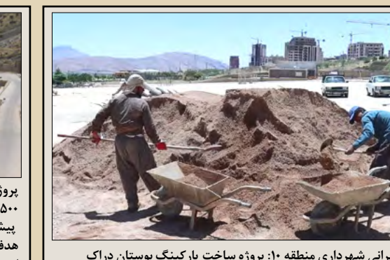
پروژه عمرانی شهرداری منطقه ۱۰: پروژه ساخت پارکینگ بوستان دراک
