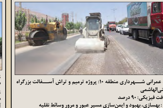
پروژه عمرانی شهرداری منطقه ۱۰: پروژه ترمیم و تراش آسفالت بزرگراه حسینی‌الهاشمی پیشرفت فیزیکی: ۹۰ درصد هدف: بهسازی، بهبود و ایمن‌سازی مسیر عبور و مرور وسائط نقلیه
