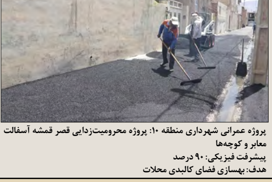
پروژه عمرانی شهرداری منطقه ۱۰: پروژه محرومیت‌زدایی قصر قمشه آسفالت معابر و کوچه‌ها پیشرفت فیزیکی: ۹۰ درصد هدف: بهسازی فضای کالبدی محلات
