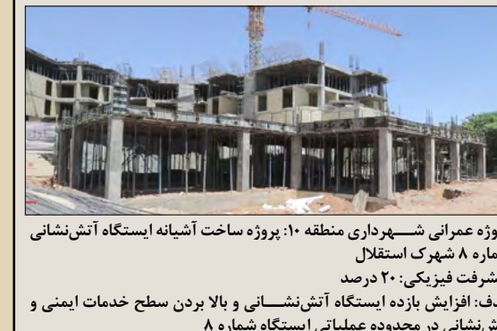
پروژه عمرانی شهرداری منطقه ۱۰: پروژه ساخت آشیانه ایستگاه آتش‌نشانی شماره ۸ شهرک استقلال پیشرفت فیزیکی: ۲۰ درصد هدف: افزایش بازده ایستگاه آتش‌نشانی و بالا بردن سطح خدمات ایمنی و آتش‌نشانی در محدوده عملیاتی ایستگاه شماره ۸
